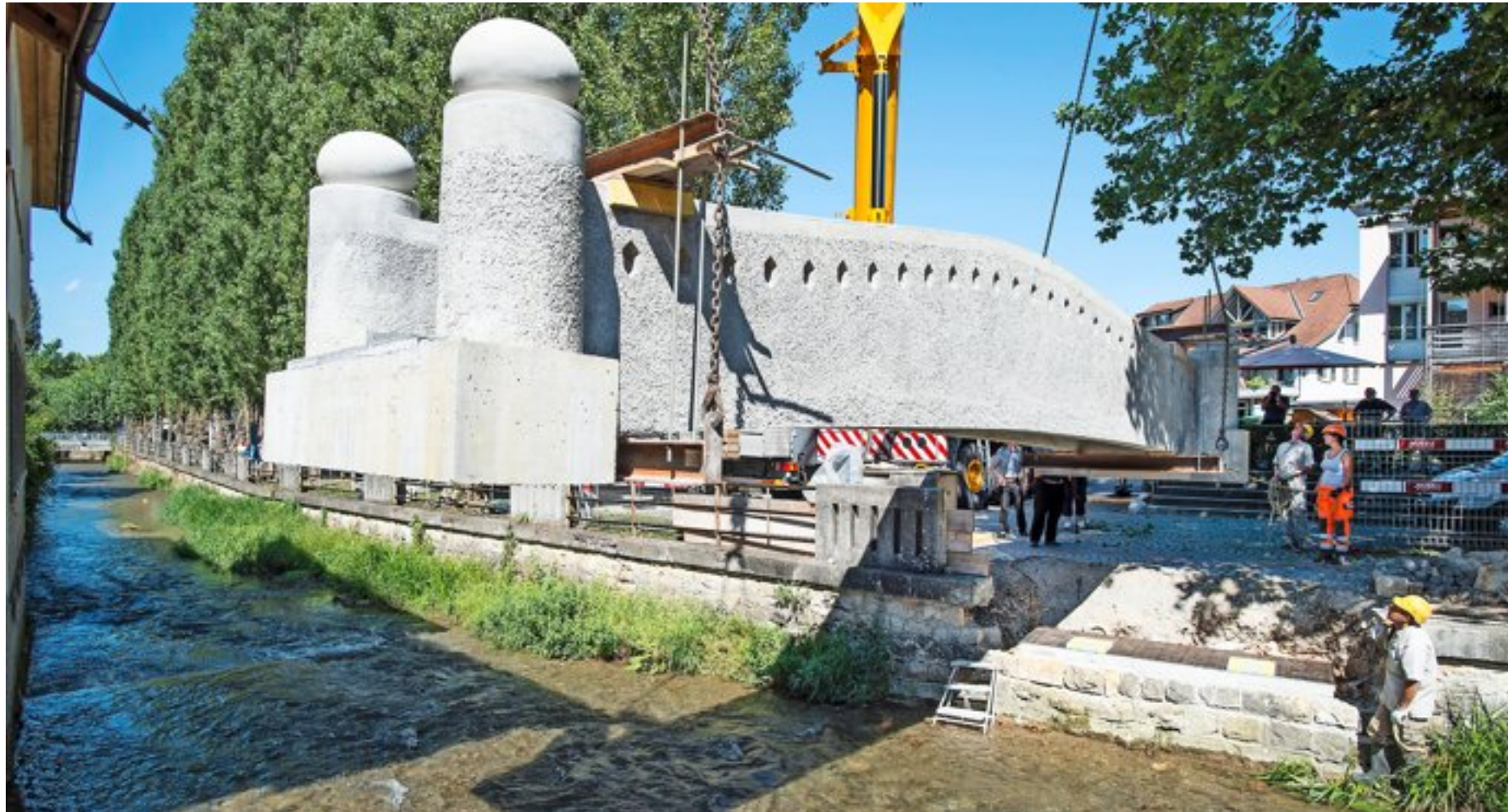
Wieder an ihrem alten Platz: Eine der beiden renovierten Lyssbachbrücken wird gesetzt.
