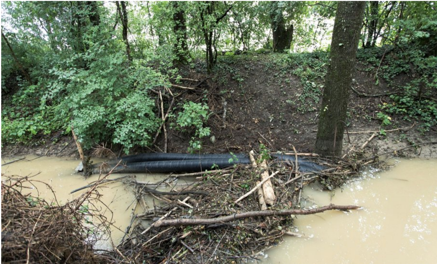
Die Drainagerohre beim Biberdamm regulieren den Wasserpegel und schützen so vor Überschwemmungen.
