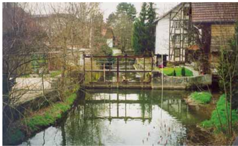
5 Das alte Wehr bei der Unterer Mühle wird wieder aufgebaut. zvg
